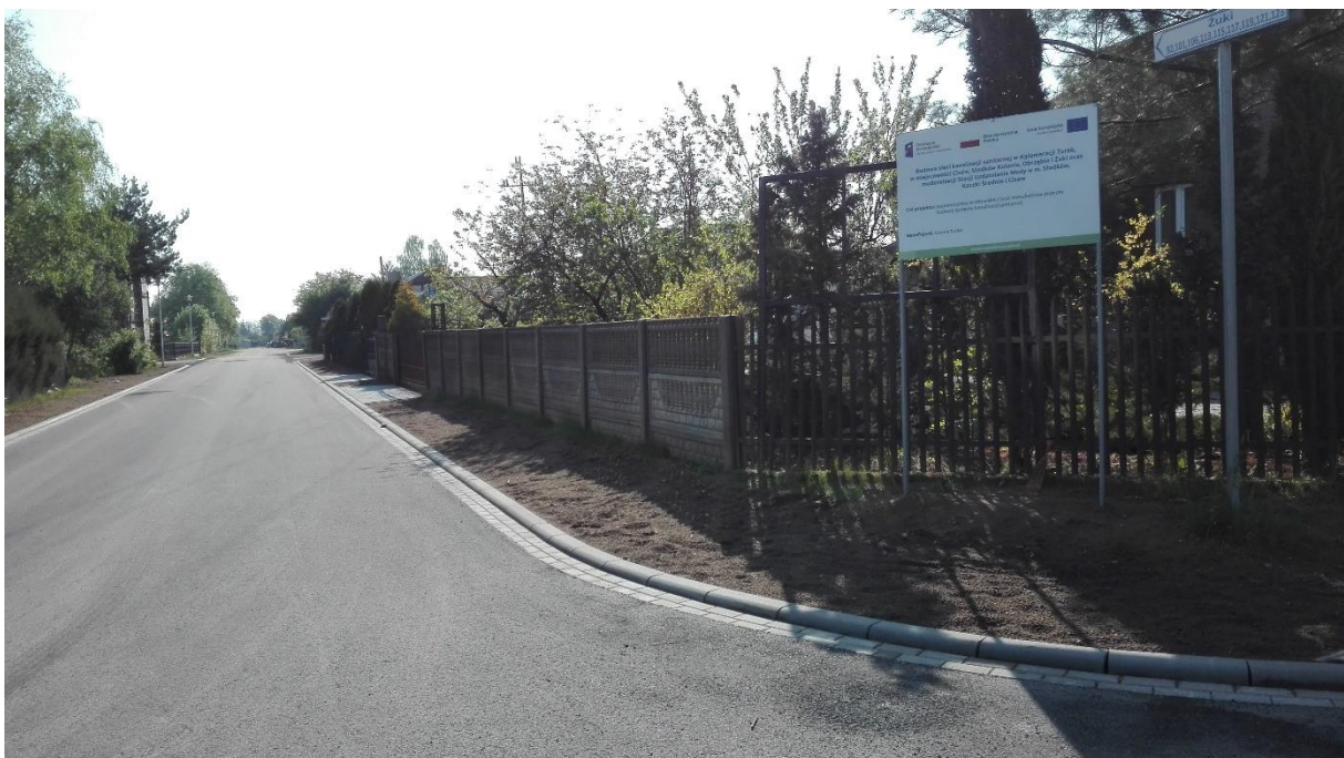
fot. Droga osiedlowa w miejscowości Żuki
