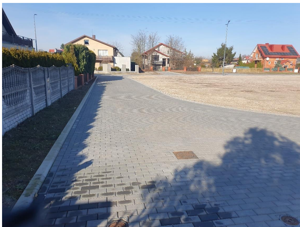
fot. Droga w miejscowości Słodków Kolonia
