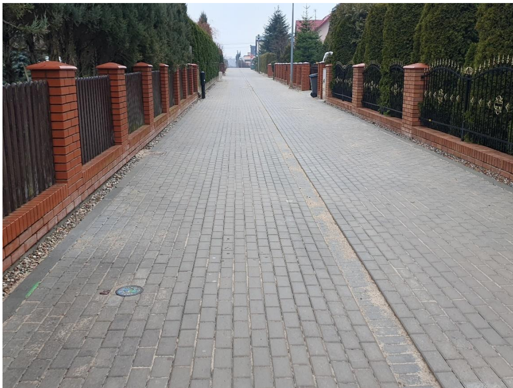
fot. Droga w miejscowości Obrzębin
