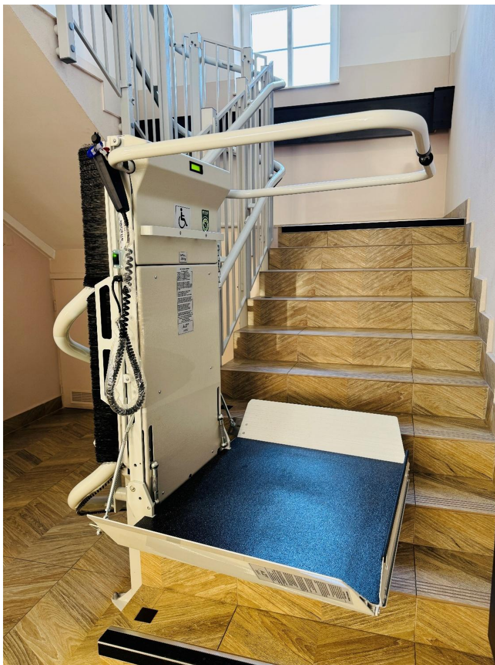
fot. Platforma przyschodowa w budynku Urzędu Gminy Turek
