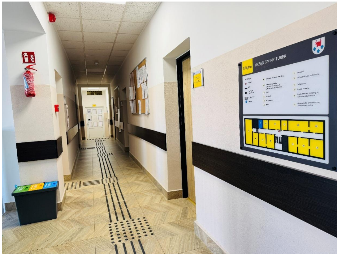
fot. Linie naprowadzające oraz plan tyflograficzny na piętrze w Urzędzie Gminy Turek
