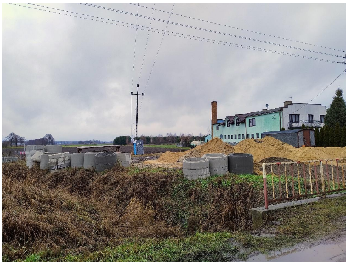
fot. Budowa sieci kanalizacji sanitarnej w miejscowości Słodków
