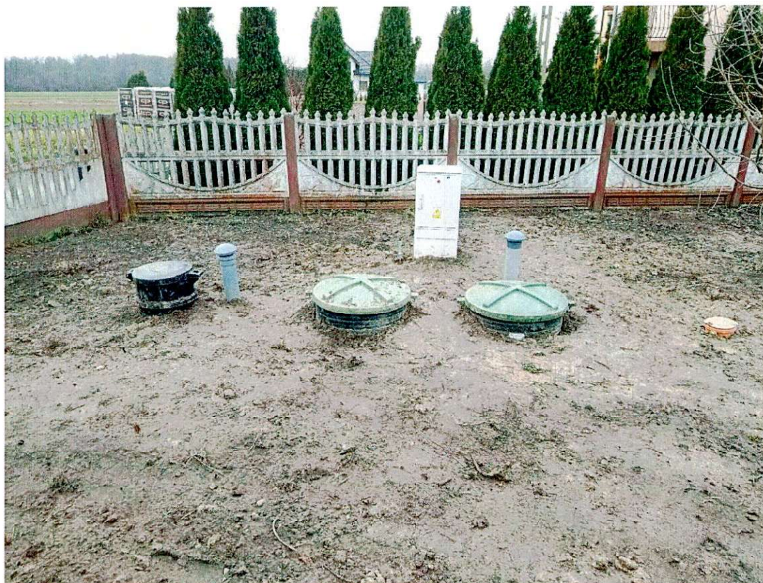
fot. Budowa biologicznych przydomowych oczyszczalni ścieków
