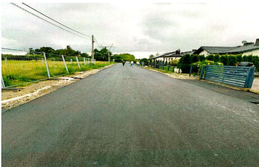
fot. Droga w miejscowości Korytków
