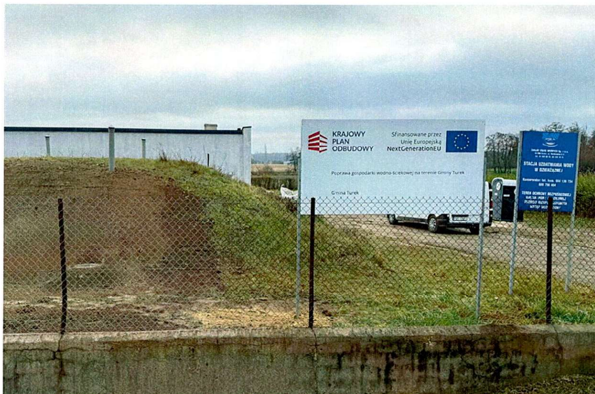
fot. Stacja Uzdatniania Wody w miejscowości Dzierżązna
